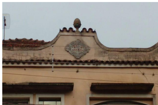
Ilustração 069 A - Prédio Avenida Brasil - Detalhe
