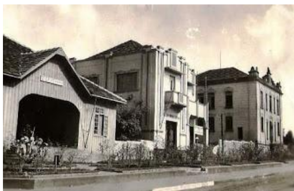
Ilustração 070 - Prédio da Câmara Municipal - Antiga
