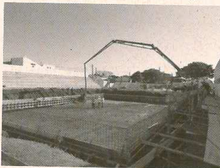
Ilustração 028 - Obras da Piscina Municipal
