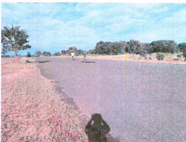
F08 - Vista da Pista de Wheeling e entorno.
