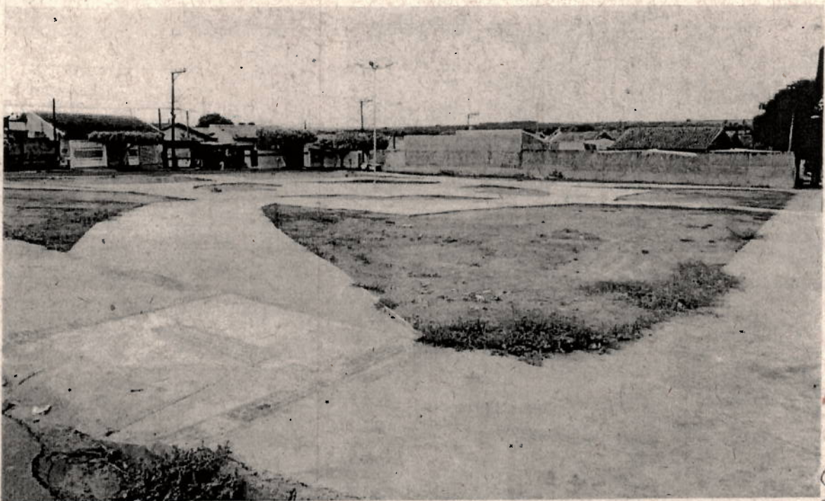
Imagem 2 – Vista do cruzamento da Rua Ary Assunção com a Rua Anísio Machado.
