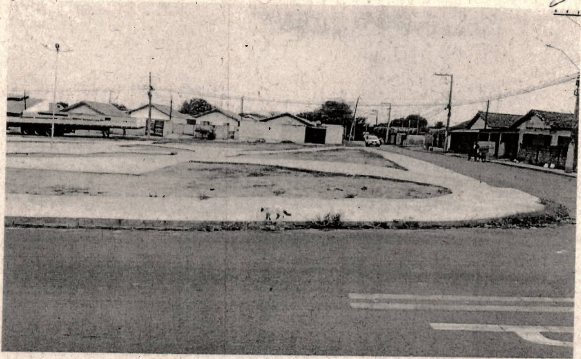
Imagem 5 – Vista pela Rua Florindo Bonini.
