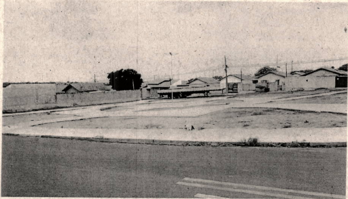
Imagem 3 – Vista do cruzamento da Rua Florindo Bonini com a Rua Anísio Machado.
