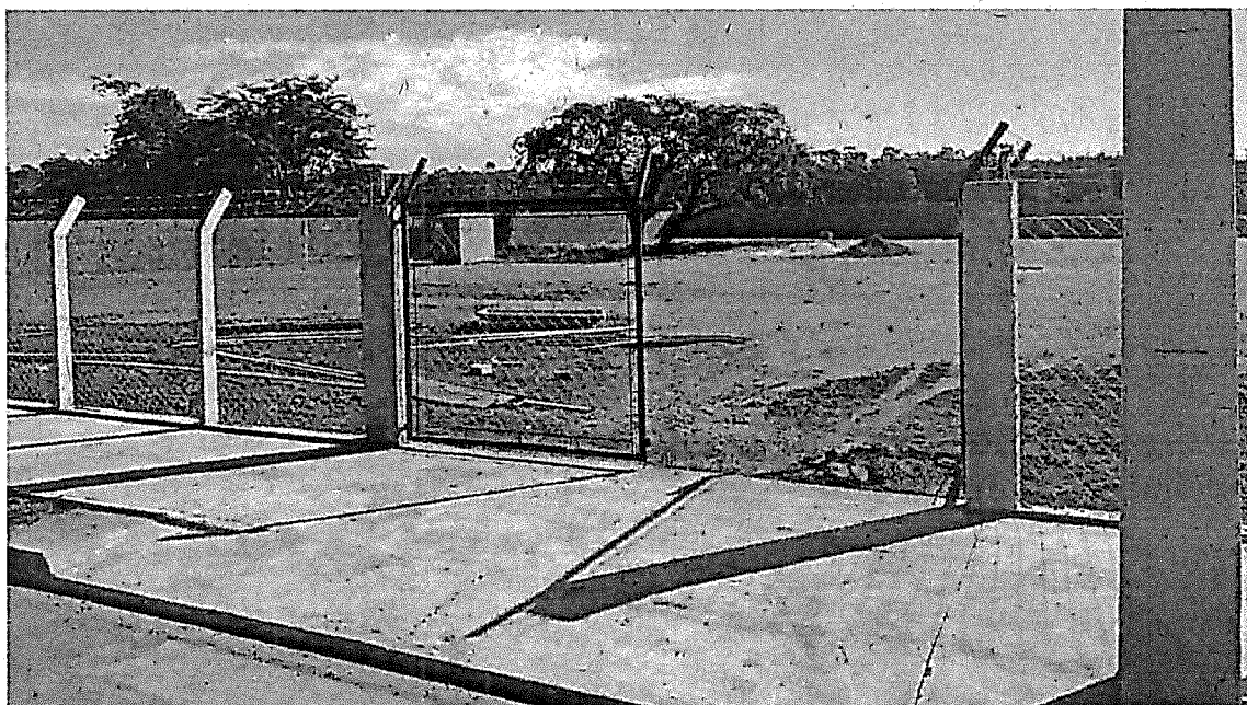
Foto 07 – Fechamento em muros de alvenaria e alambrado da Área Institucional
