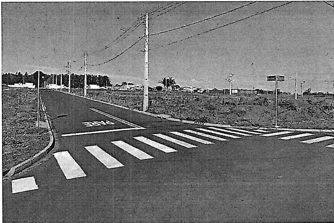
Foto 05 – Rede de Energia Elétrica, sinalização Horizontal e Identificação de Ruas
