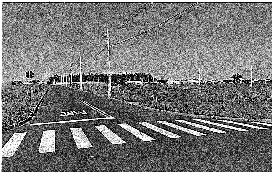
Foto 02 - Pavimentação Asfáltica, Guias, Sarjetas e Iluminação Pública
