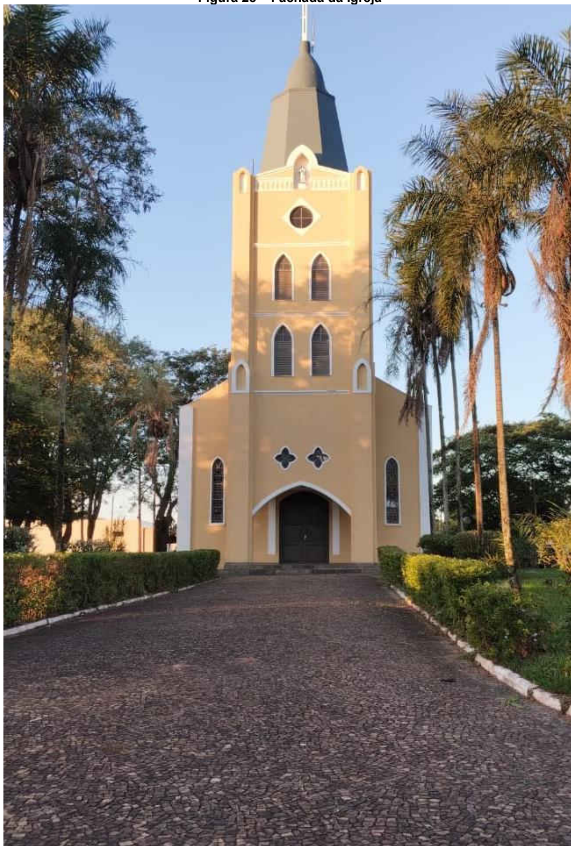
Figura 28 – Fachada da Igreja
