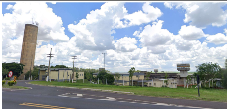
Imagem 1 – Fachada do imóvel
