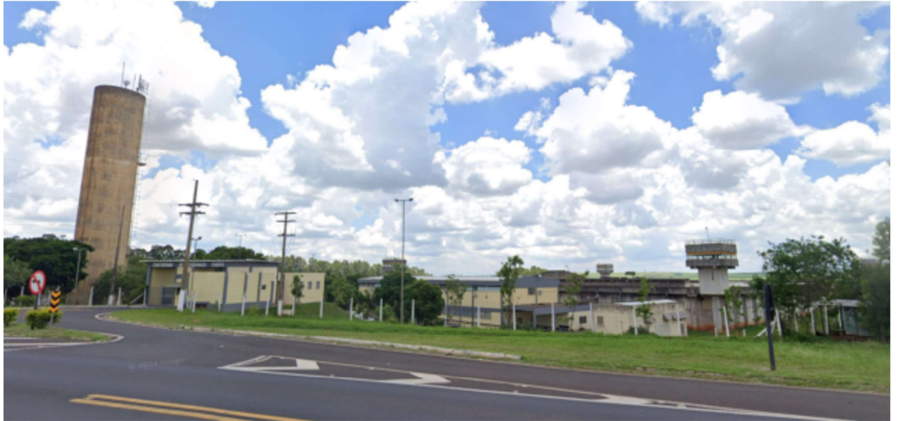
Imagem 1 – Fachada do imóvel
