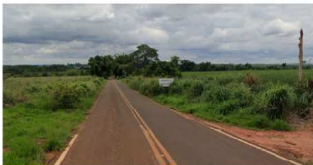
Imagem 2 – Vista para a Rodovia SP 284 Km
