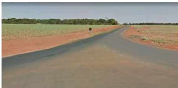
Imagem 3 – Frente do lote – Entrada pela Rodovia SP 284 Km
