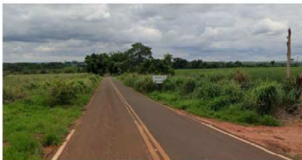
Imagem 2 – Vista para a Rodovia SP 284 Km
