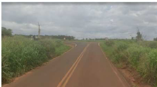
Imagem 3 – Frente do lote – Entrada pela Rodovia SP 284 Km
