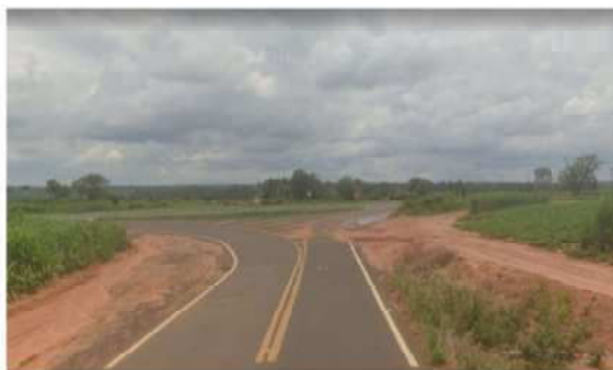
Imagem 2 – Vista para a Rodovia SP 284 Km
