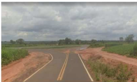
Imagem 2 – Vista para a Rodovia SP 284 Km
