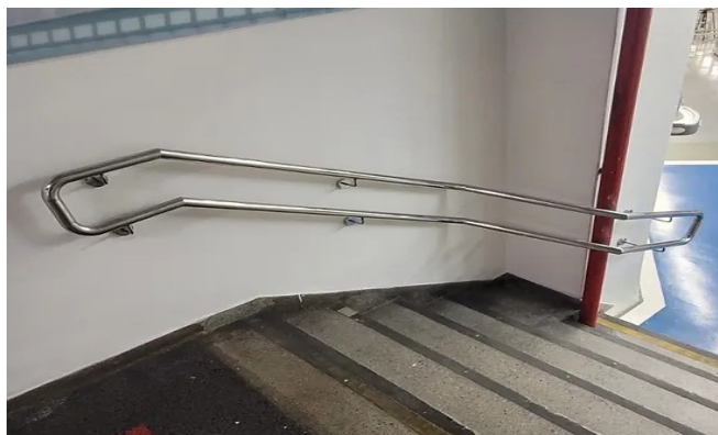
FIGURA 10 : CORRIMÃO DUPLO FIXADO NA ALVENARIA ( MODELO 3 )
